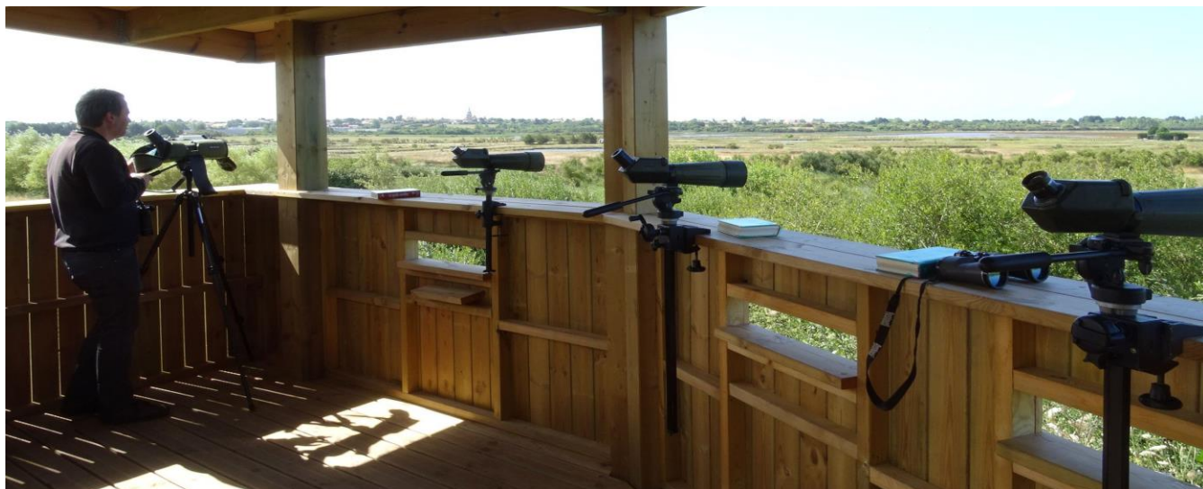
un nouveau poste construit en avril 2015
